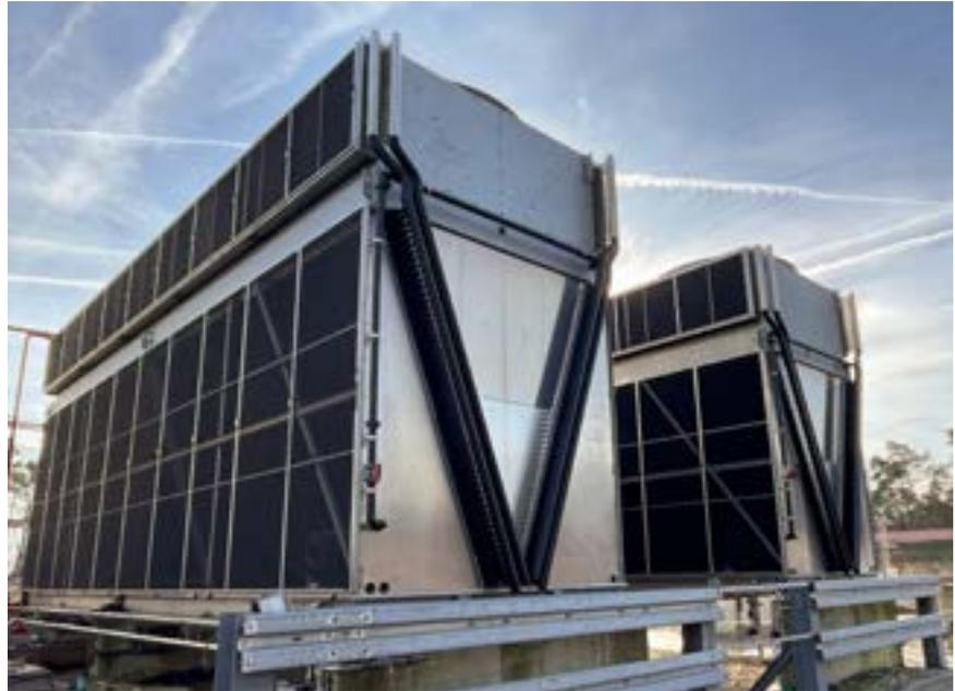
**Bereits seit 2011 setzt Storck im Kühlprozess Hybridrückkühler ein, die im Vergleich zu alternativen Anlagen rund 35% weniger Energie benötigen.**
