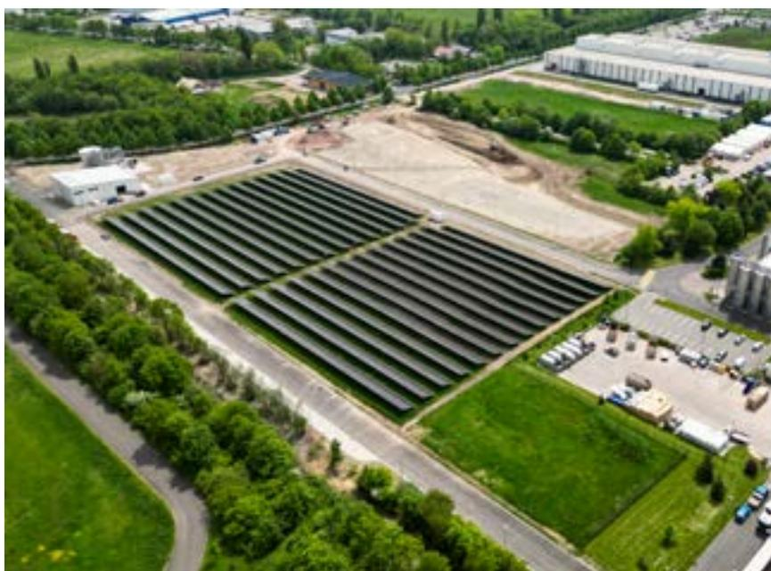
**Auf dem Werksgelände in Ohrdruf** hat Storck eine Photovoltaikanlage mit einer Fläche von mehr als 16.000 Quadratmetern errichtet.
